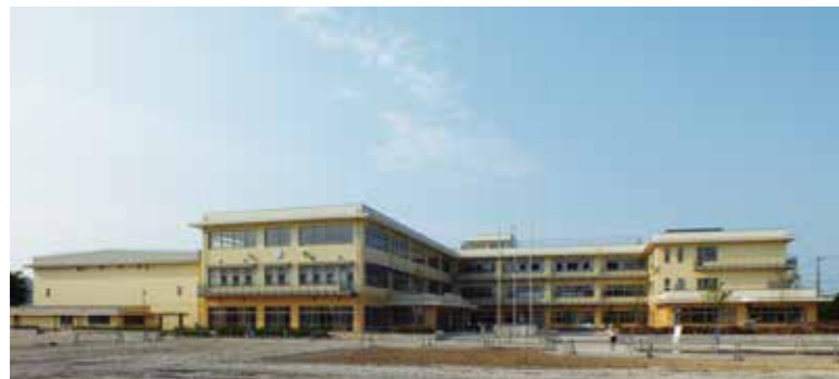
▲福岡小学校校舎・体育館完工
