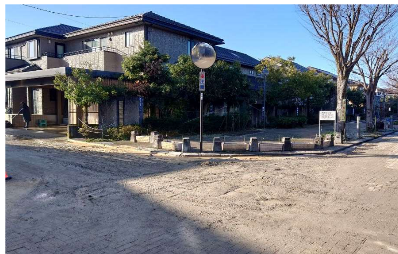
横田町二丁目地内の市道
