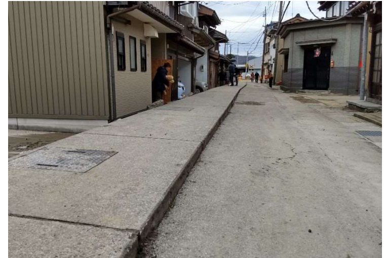
吉久一丁目地内の市道
