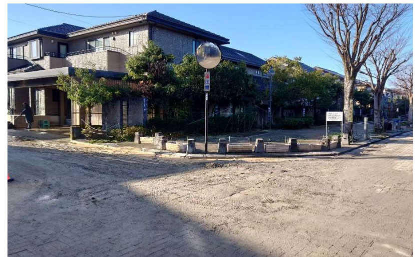
横田町二丁目地内の市道
