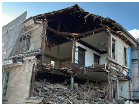
解体される旧伏木銀行
