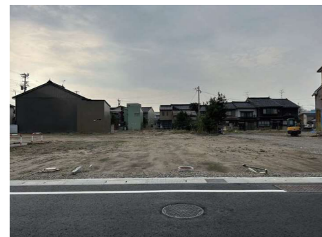
解体により広がる空き地
