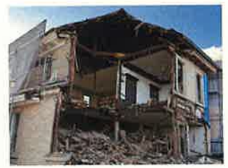
解体される旧伏木銀行
