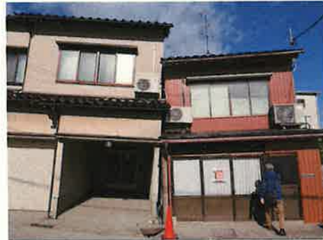
液状化被害によって傾いた建物
