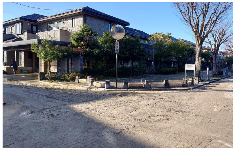
横田町二丁目地内の市道
