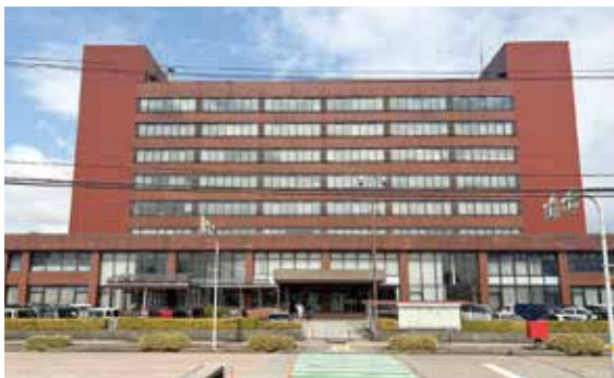
今後のあり方を検討している市役所本庁舎
