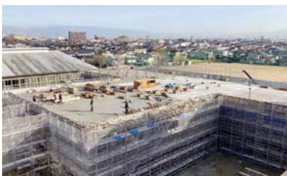
高陵中学校区小中一貫校校舎新築及び改修工事
