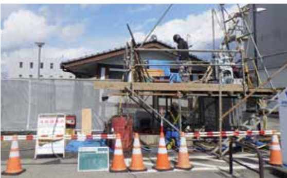
伏木駅前のボーリング調査の様子
