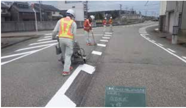
老朽化した区画線の引き直し
