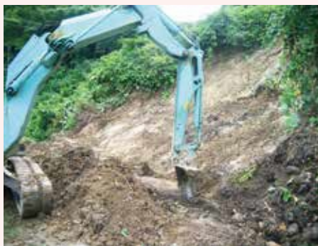
令和5年7月の大雨災害からの復旧が進む
