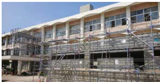
高岡西部中学校区統合小学校校舎改修・増築工事
