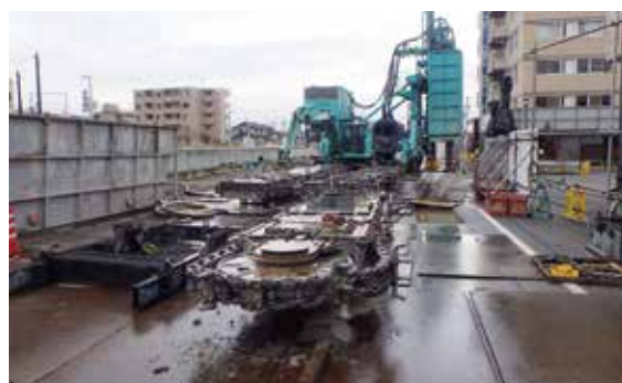
下伏間江福田線京田地下道工事
