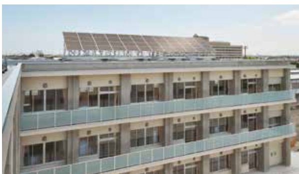
公共施設への太陽光パネルの設置
