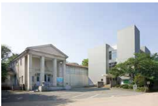
昭和26年に建てられた市立博物館
