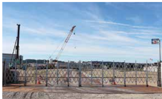
工事が進む五位中学校区統合小学校
