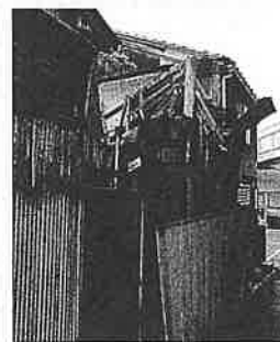
▲空き家の除去
