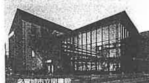
多賀城市立図書館
