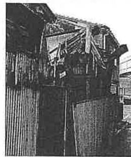
▲空き家の除去
