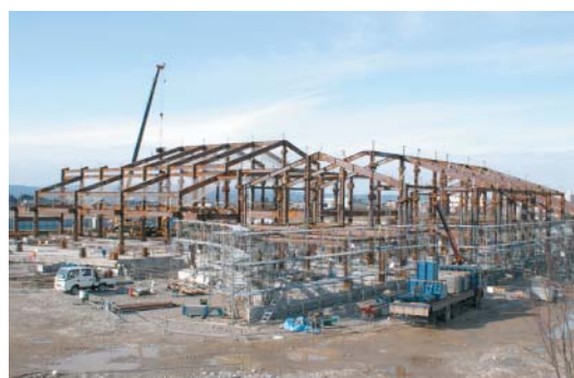
建設工事が進む総合斎場
