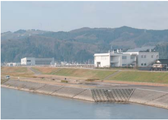
災害時の応急活動の拠点・福岡防災センター
