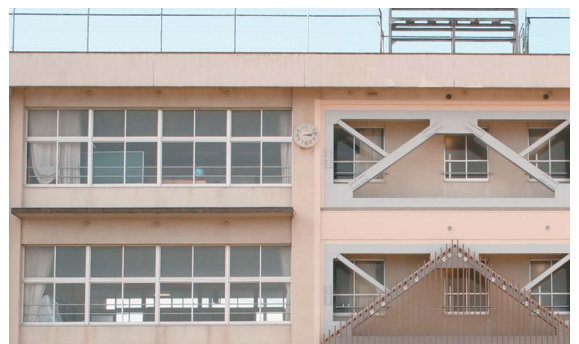
耐震化工事を実施した校舎
