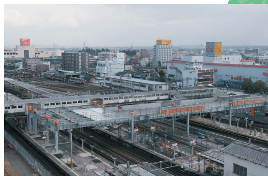
橋上駅舎の鉄骨が姿を現したJR高岡駅
