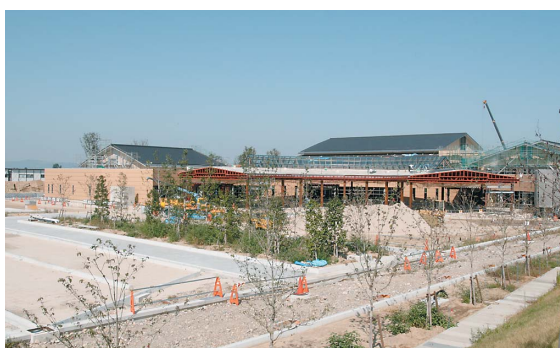
建設が進む総合斎場
