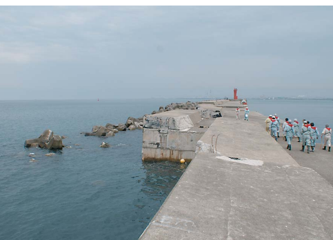
高波で陸地側へ後退した北防波堤
