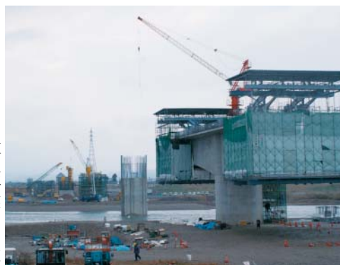
新幹線庄川橋りょう工事 槌音響く
