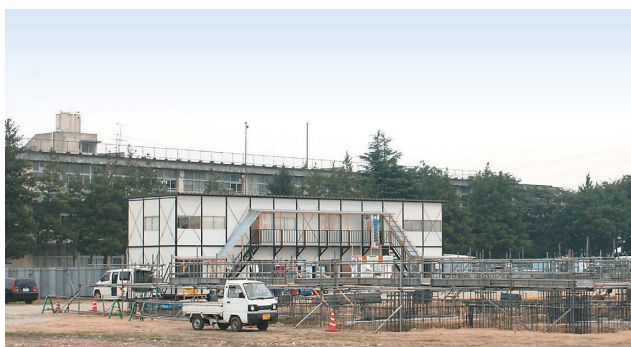
改築工事が始まった戸出東部小学校
