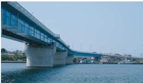
まもなく開通、伏木万葉大橋
