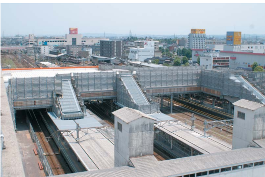
工事が着々と進む高岡駅
