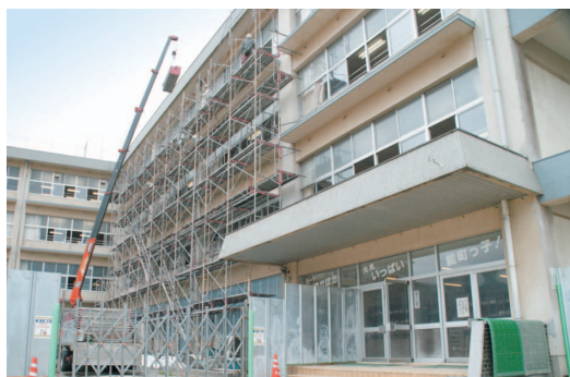
校舎の耐震補強工事を実施(能町小学校)
