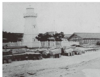
明治10年(1877)に完成した西洋式灯台
