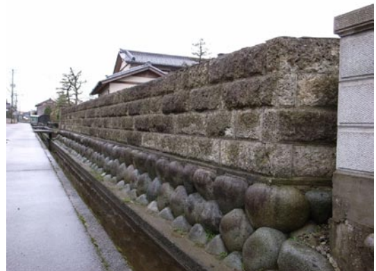
出来田地区内の水路の様子
