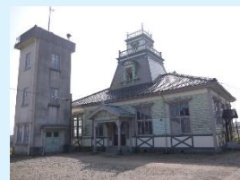
旧伏木測候所
