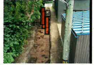
発掘当時 下水道古府串岡地区
