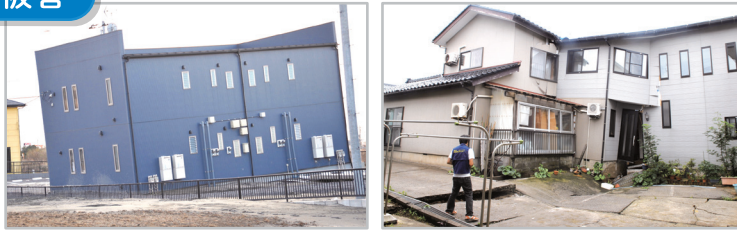
沈下及び一体傾斜(左)、変形傾斜(右)など
