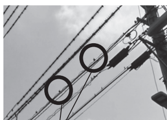
▲対策部材設置箇所
