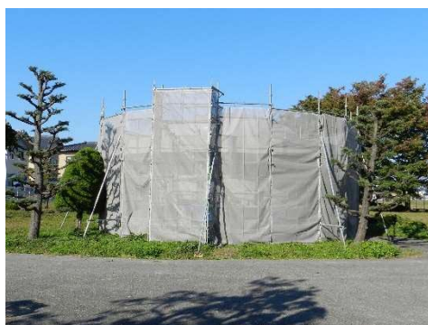
【佐野取水場3号井補修工事】
