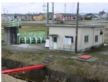
【石瀬ポンプ場】
