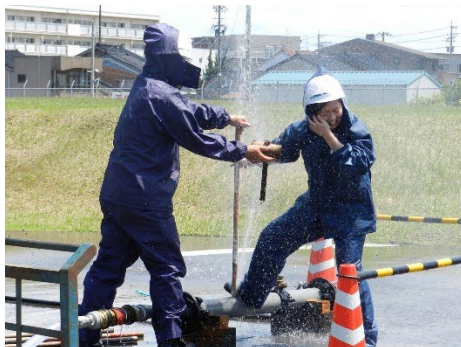
【応急復旧訓練の様子】
