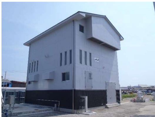
【住吉ポンプ場雨水施設(建屋)】
