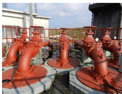
【ポンプ施設の塗装塗替工事】
