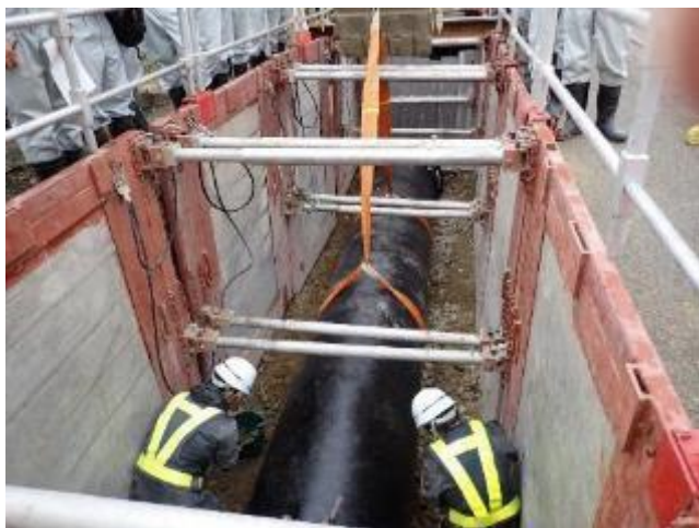
配水管(口径900mm)の布設替
