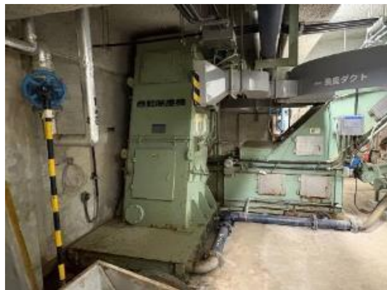
除塵機装置の改築・更新(伏木)
