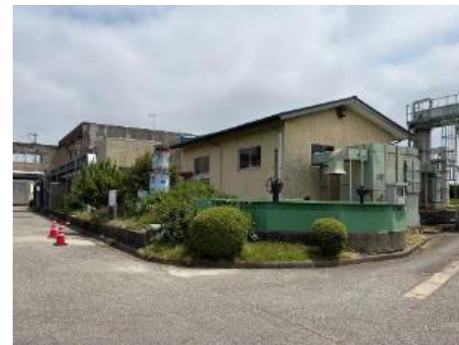
四屋浄化センターの耐震補強
