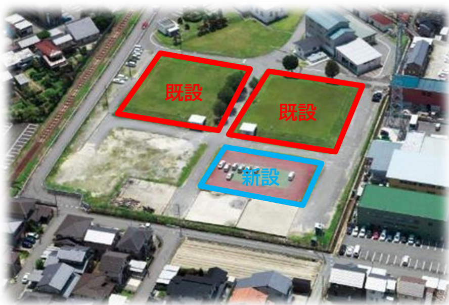
既設の地下式配水池及び新設配水池予定地
