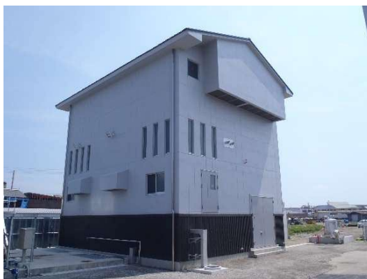
【住吉ポンプ場雨水施設(建屋)】
