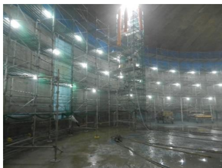
【国吉配水池内槽改修工事】
