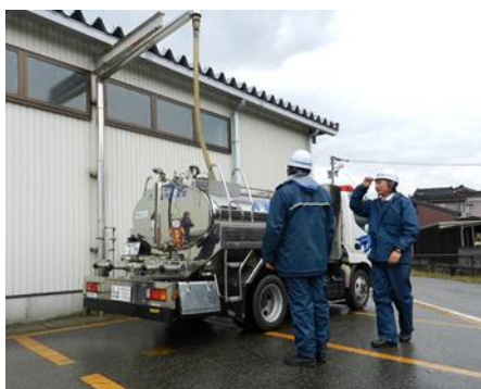
【上関浄水場内の応急給水施設】
