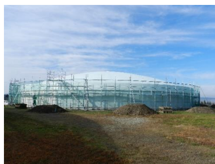
【中田配水場 1号配水池外部改修工事】
