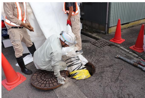
【管更生工事】（更生管材挿入の様子）
