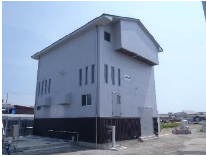
【住吉ポンプ場雨水施設（建屋）】
