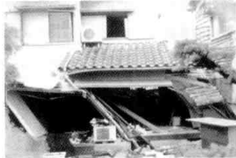
耐力壁の不足で傾斜した住宅
