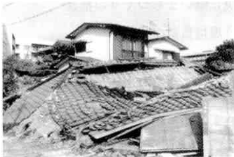
耐力壁の不足と老朽化による倒壊
