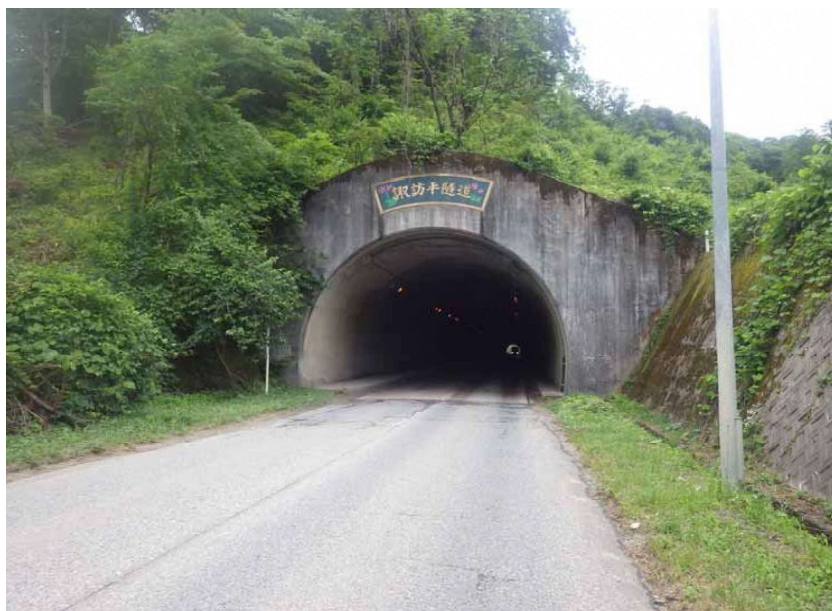
【写真：諏訪平トンネル】
