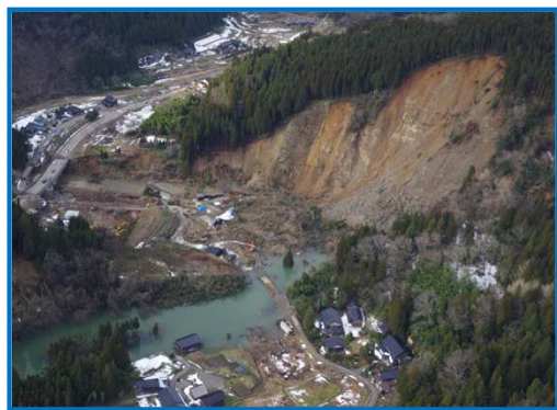
河原田川の斜面崩壊（R6.1能登半島地震）
