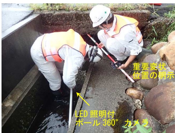
写真 13.17 桁下撮影例(狭隘部)
