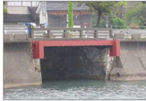
応急対策工（H形鋼の架設）
