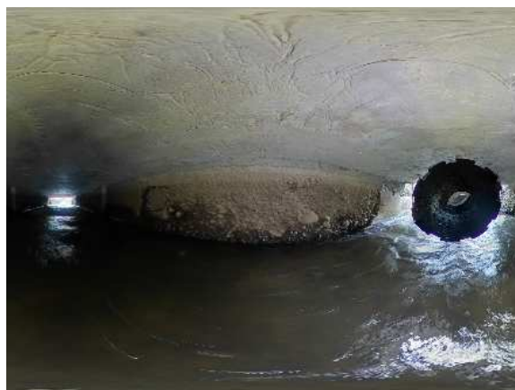
写真 13.16 桁下撮影例(狭隘部・360° カメラ)
