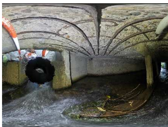
写真 13.18 桁下撮影例(狭隘部・360° カメラ)
