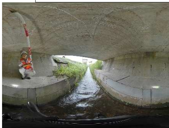
写真 13.14 桁下撮影例 (360° カメラ)
