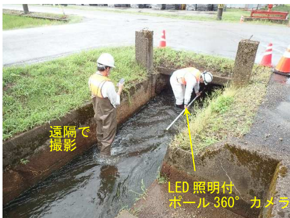
写真 13.15 桁下撮影例(狭隘部)
