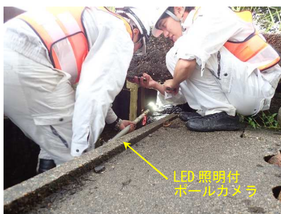
写真 13.20 重要変状の状態把握例（狭隘部 減肉を伴う局所的でない鉄筋露出撮影例）
