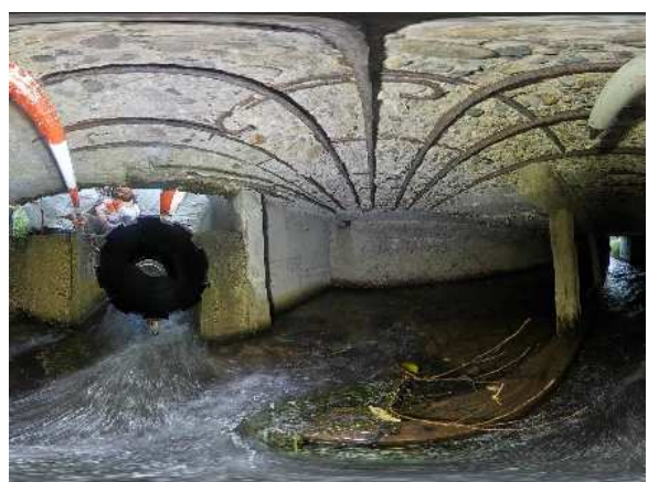
写真 13.18 桁下撮影例(狭隘部・360° カメラ)
