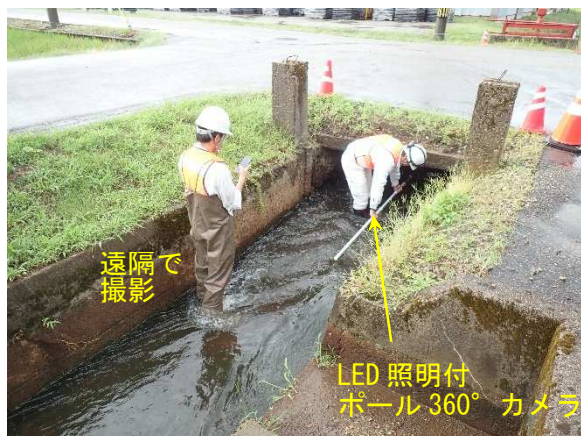
写真 13.15 桁下撮影例(狭隘部)
