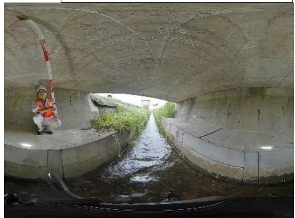
写真 13.14 桁下撮影例 (360° カメラ)
