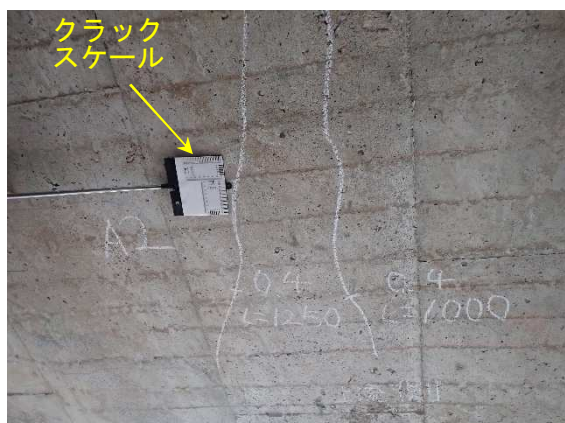
写真 13.19 重要変状の状態把握例（ひびわれ撮影例） ※損傷マーキングはイメージ
