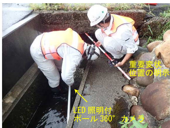
写真 13.17 桁下撮影例(狭隘部)
