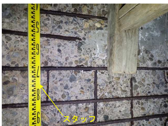
写真 13.20 重要変状の状態把握例（狭隘部 減肉を伴う局所的でない鉄筋露出撮影例）
