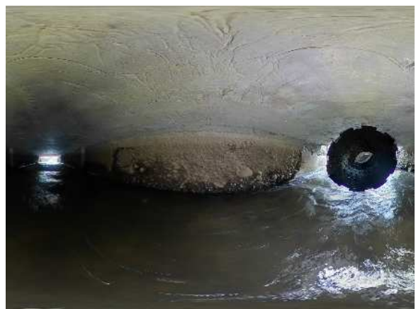
写真 13.16 桁下撮影例(狭隘部・360° カメラ)
