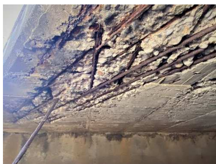
減肉を伴う局部的でない鉄筋露出
