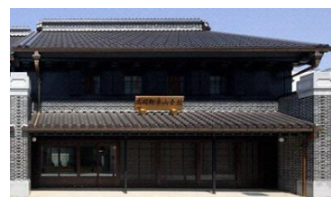
高岡御車山会館建設事業 H27.4
