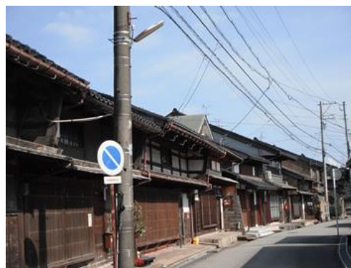
町並み景観を阻害する電線類
