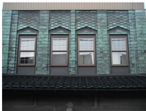
銅板建築の店舗
