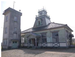
旧伏木測候所
