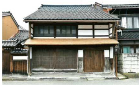
⑤【吉久地区】大谷家主屋工事完了後
