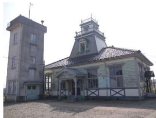
旧伏木測候所
