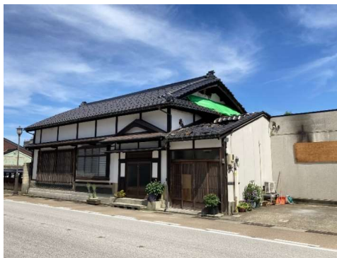
①【山町筋地区】中条家住宅工事着手前
