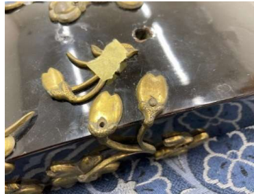
金具洗浄具合確認(高欄)
