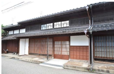
⑤【吉久地区】デイサービスむら花工事完了後
