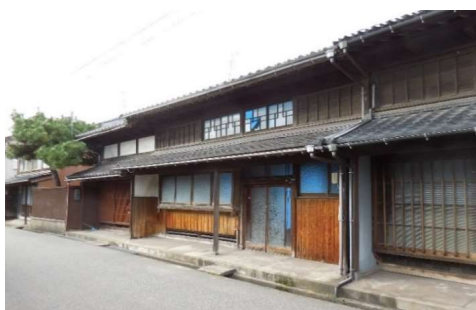
⑤【吉久地区】デイサービスむら花工事着手前
