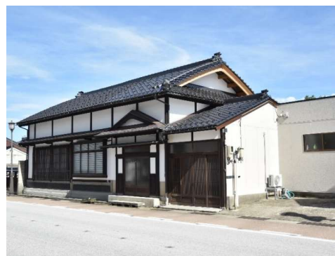
①【山町筋地区】中条家住宅工事完了後
