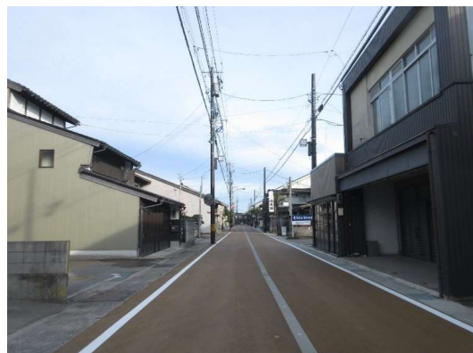
工事後(電柱、側溝、消雪管、舗装)の状況
