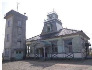
旧伏木測候所
