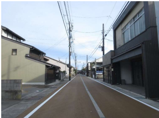
県道岡・笹川線道路整備事業
