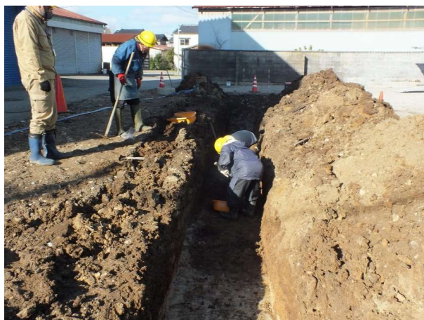
試掘調査の様子
