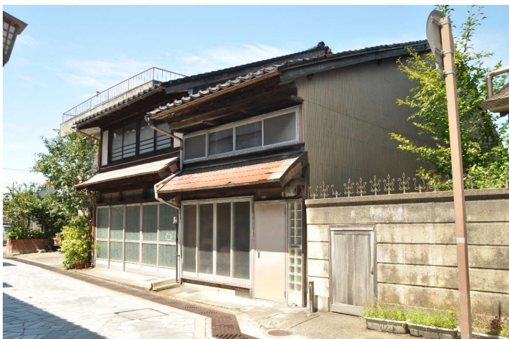
【鍛冶家住宅主屋[東棟,西棟]】修理前
