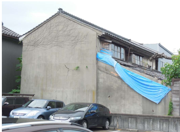
【室崎家住宅土蔵】修理前
