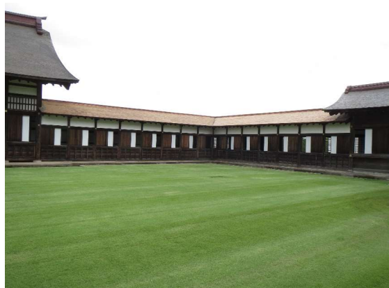
【北回廊】工事完了 ②
