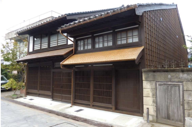
【鍛冶家住宅主屋[東棟,西棟]】修理後
