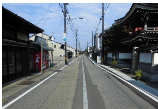
工事後(電柱、側溝、消雪管)の状況
