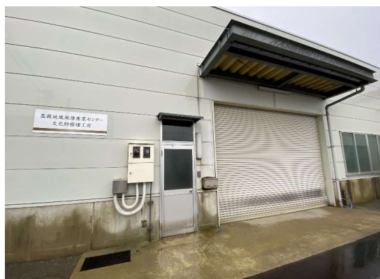
・移転した文化財修理工房(外観)
