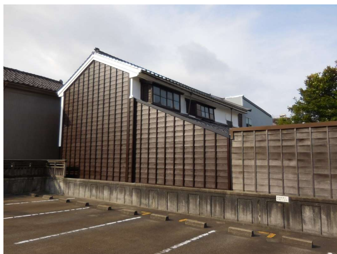
【室崎家住宅土蔵】修理後
