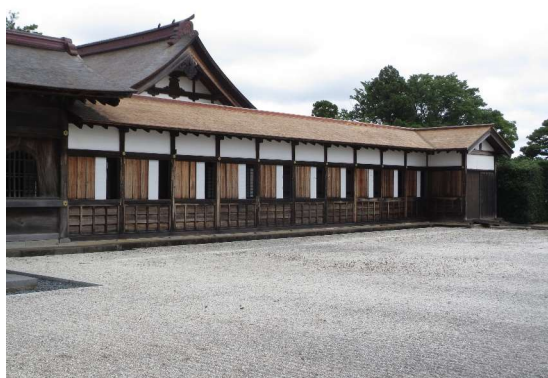
【北回廊】工事完了 ①
