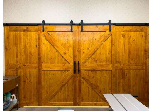
追加防音扉工事写真
