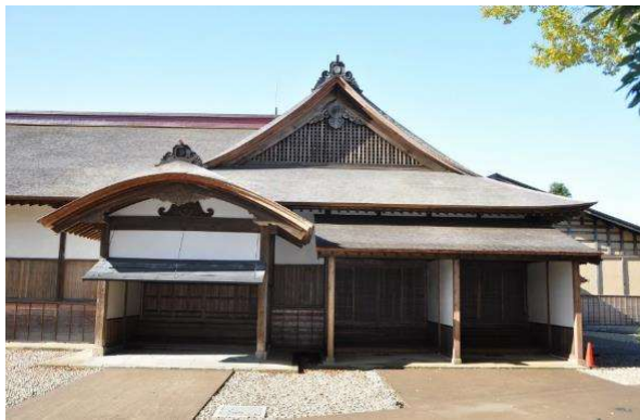
【式台玄関、式台脇玄関】修理完了 ①
