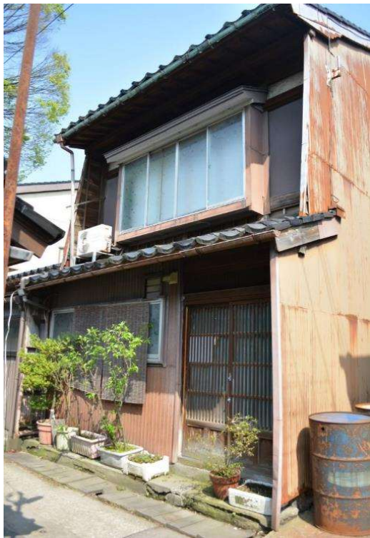
【金森家住宅主屋】修理前
