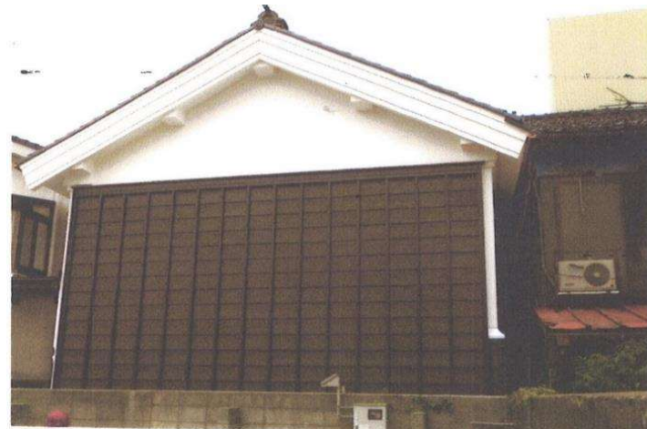
【堀井家住宅土蔵】修理後
