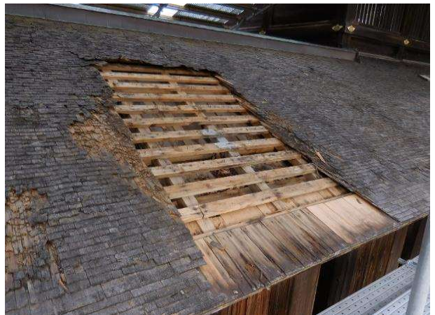
【北回廊】既存野地確認状況 ②
