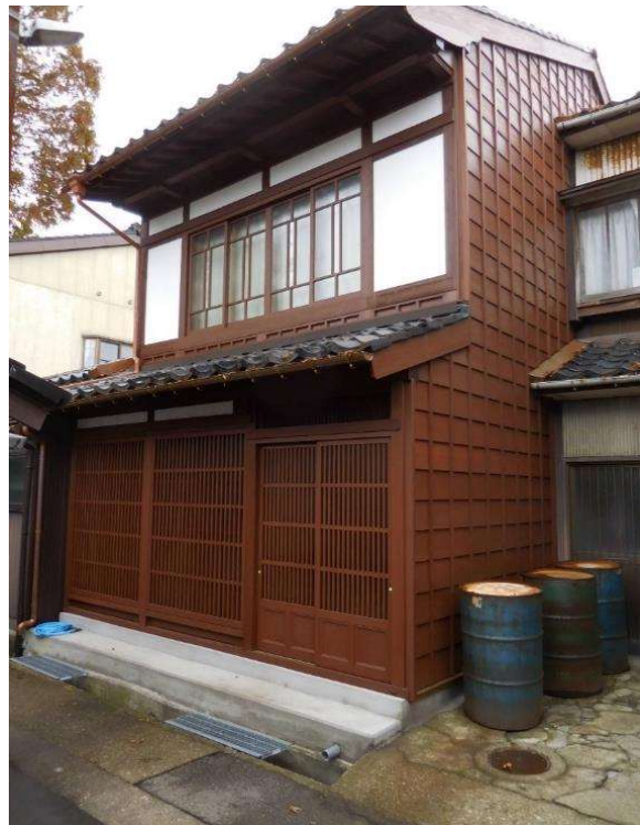
【金森家住宅主屋】修理後
