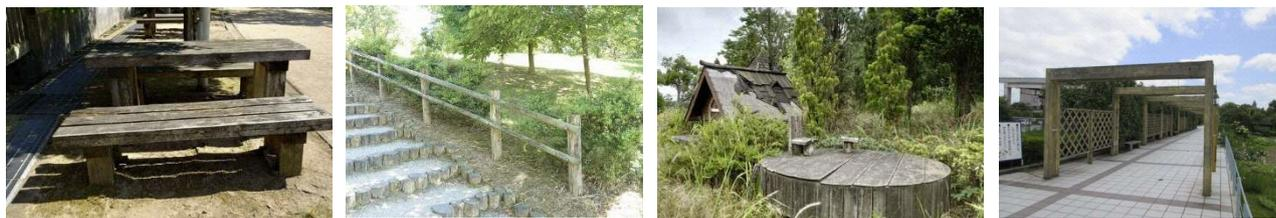
老朽化した施設一例（木材の腐食・壊れ）
