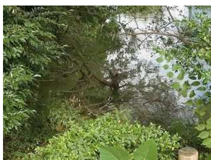
写真-3-14 堀に落ちている樹木
