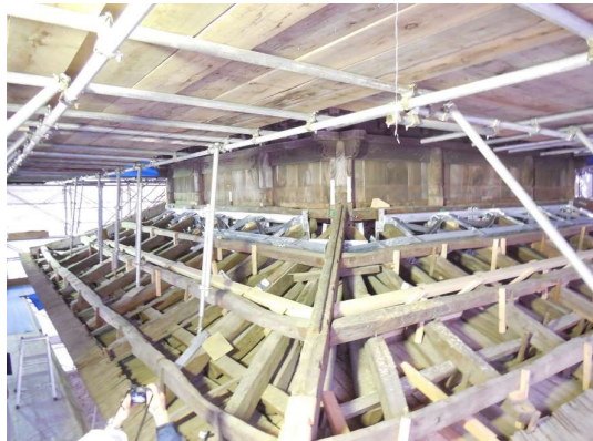
【経堂】構造補強工事 ①
