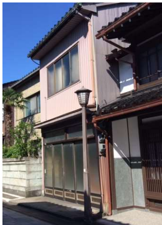
【大島家住宅主屋】修景前
