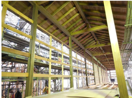
【本堂渡り廊下】木工事中 ②
