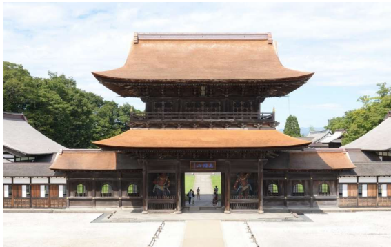
【山門】屋根葺き替え完了 ①
