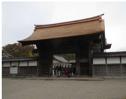
【瑞龍寺：総門】屋根葺き替え完了
