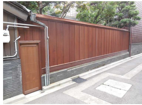
【山内家住宅塀】修理後
