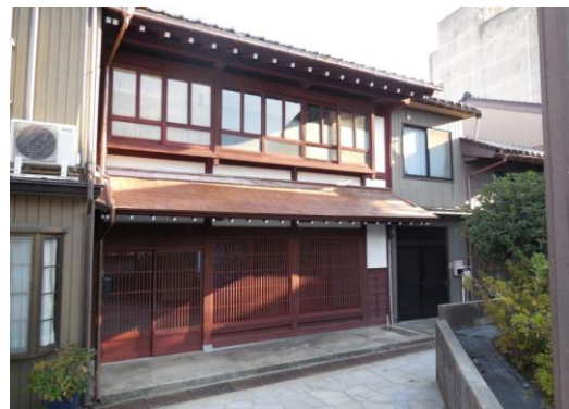
【旧夏野家住宅主屋】修理後
