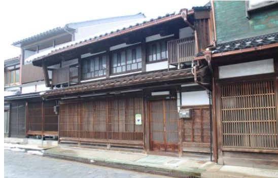
【般若家住宅主屋】修理後
