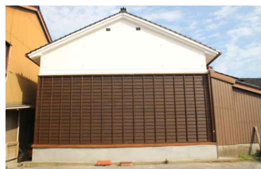
【羽岡家住宅土蔵】修理後
