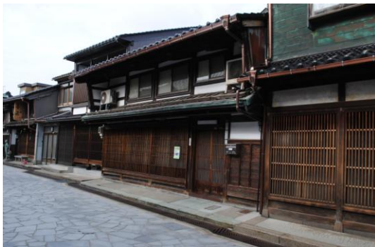
【般若家住宅主屋】修理前
