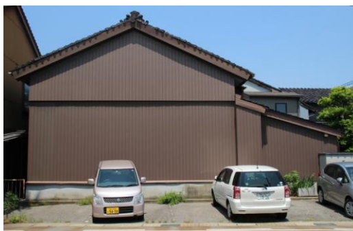
【羽岡家住宅土蔵】修理前
