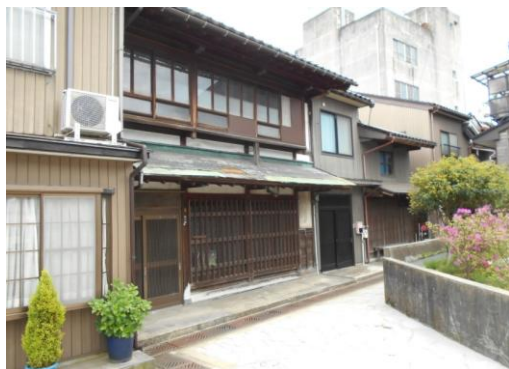
【旧夏野家住宅主屋】修理前
