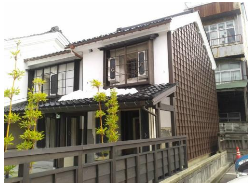
【旧谷道家住宅土蔵】修理後
