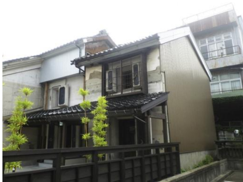
【旧谷道家住宅土蔵】修理前
