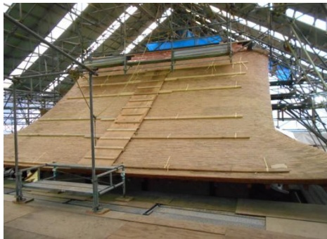
【勝興寺】屋根工事
