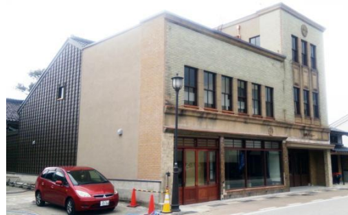
【旧谷道家主屋】修理後
