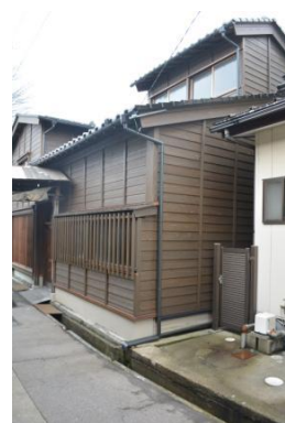
【神初家作業場】修理後
