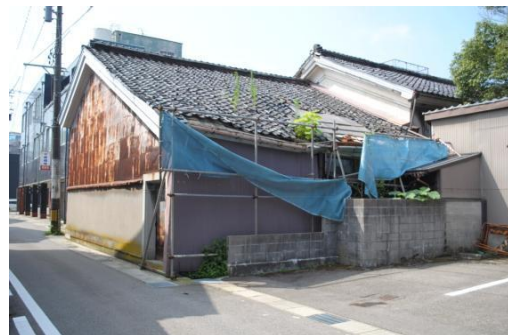
【旧谷道家土蔵】修理前
