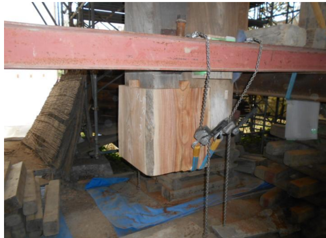
【式台門】木工事(柱根継ぎ)
